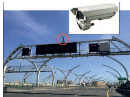
Магистраль Западный скоростной диаметр в С.-Петербурге: стационарные камеры наблюдения защищены кожухами HEG со стеклоочистителем
